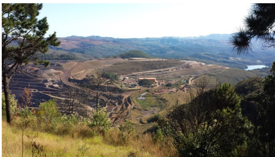
Figura 4: Mina do Tamanduá hoje – cava, pilha de estéril e barragem de rejeito FONTE: Geoconômica
